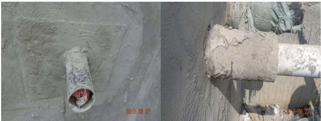
7、地下室防水卷材基层未施工 R 角，套管部位细部做法不合理。
