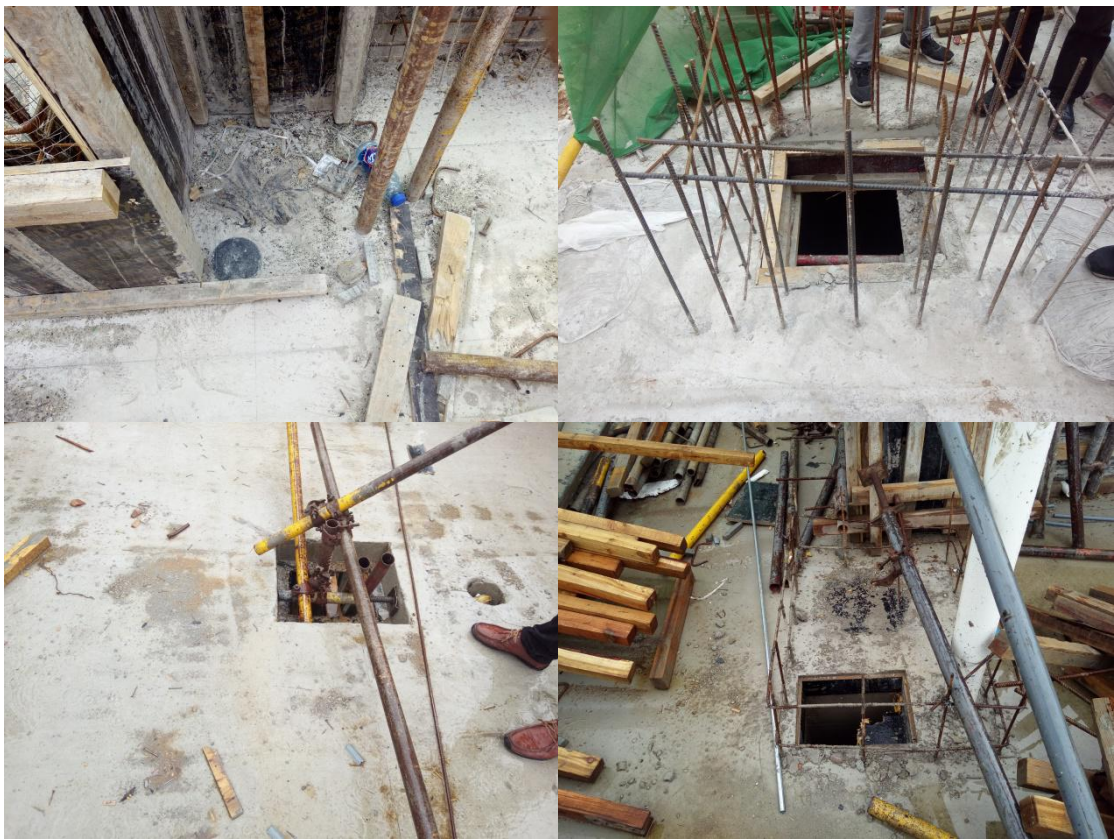
7、地下室防水卷材基层未施工 R 角，套管部位细部做法不合理。
