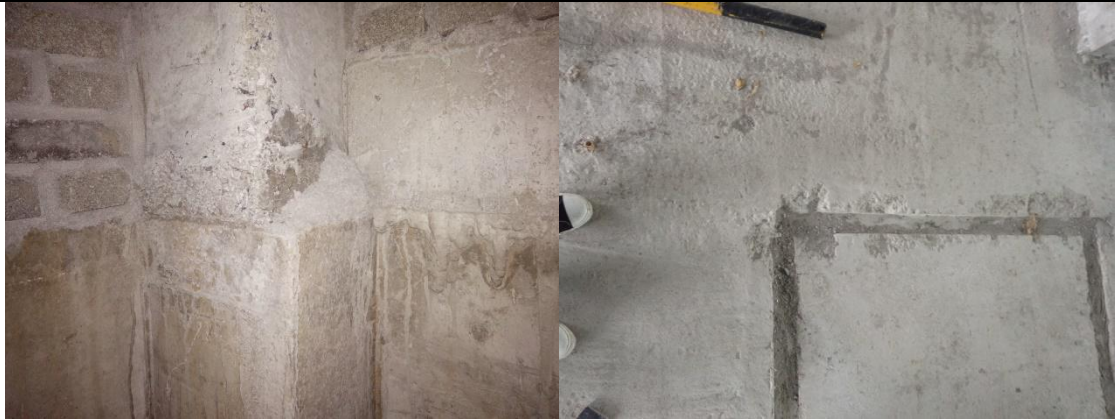
19、现场砌体存在断砖、缺棱掉角、瞎缝、假缝、灰缝大小不一、未双面勾缝等问题。
