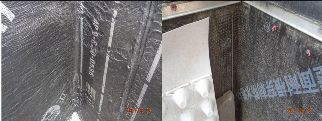
8、施工现场露台及屋面结构上返 200mm 范围内采用对拉螺杆。
