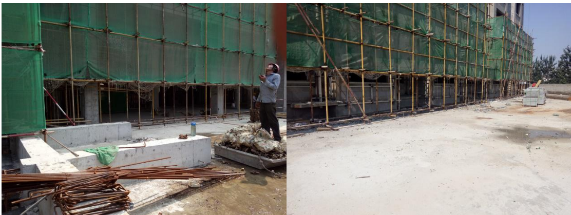
3、外脚手架密目网封闭不严密。
