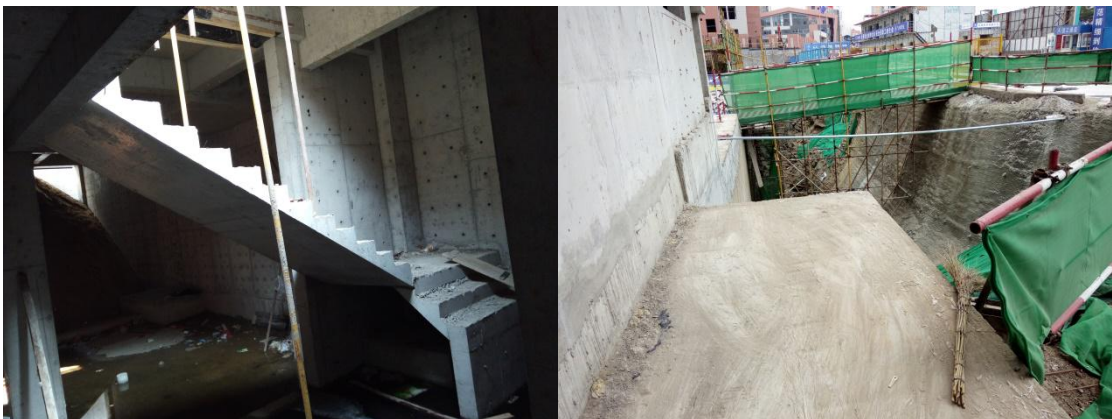
2、预留洞口、楼层、楼梯临边、集水井防护缺失，作业层外架进度滞后。
