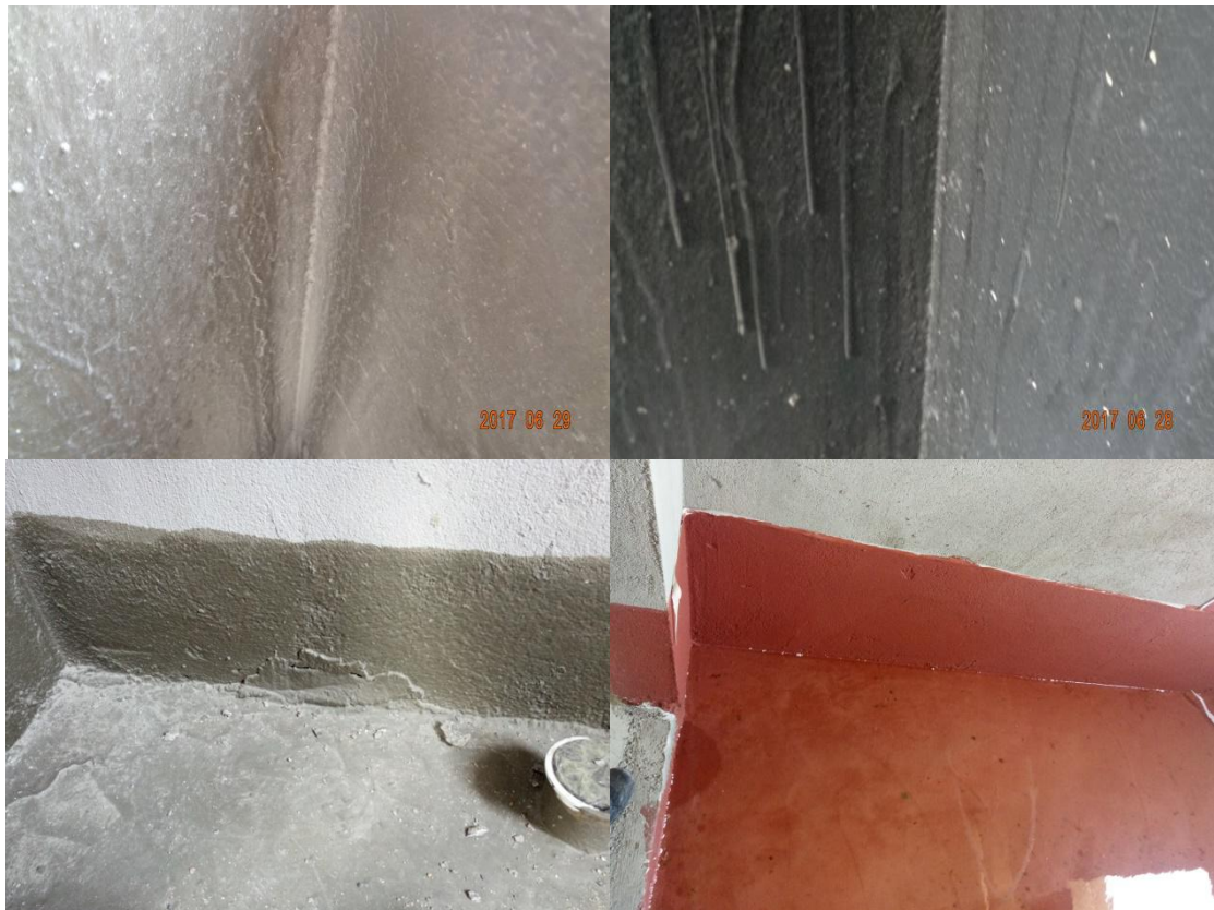
11、现场卫生间基层处理不到位，阴角部位未按照要求设置 R 角。
