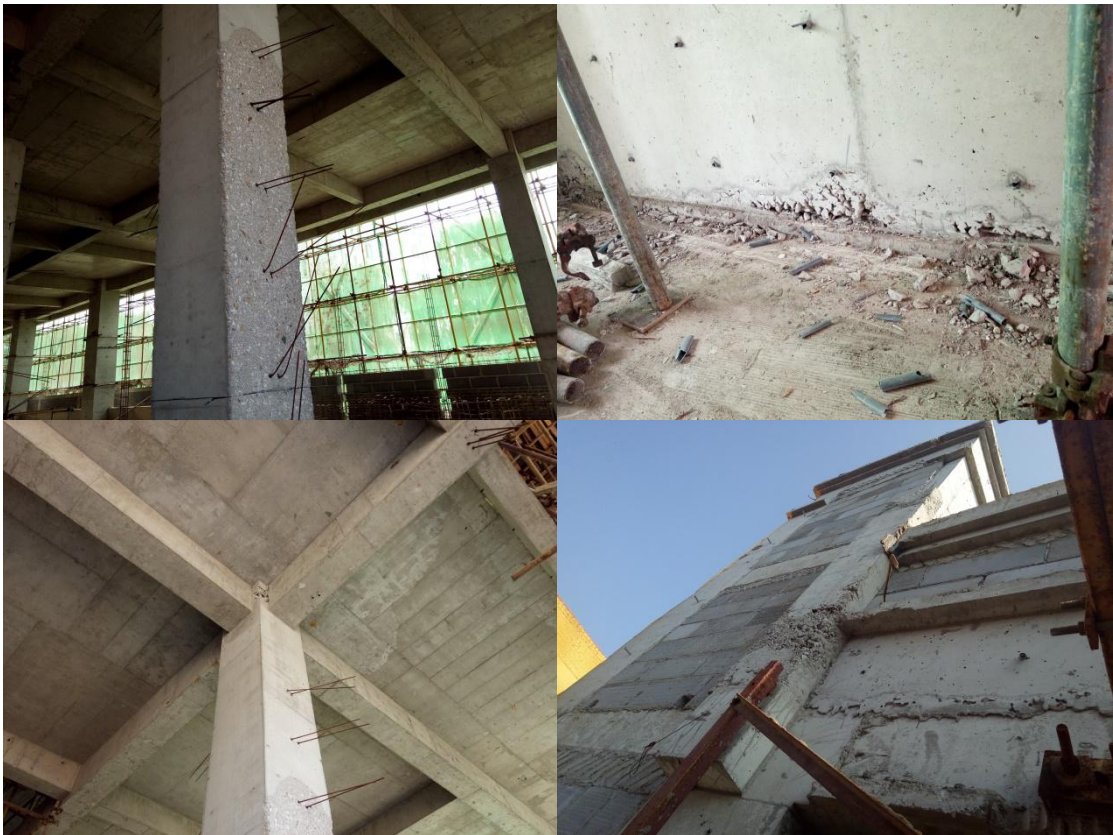
18、现场混凝土结构存在胀模、烂根、错台、露筋、漏浆、崩边等现象。
