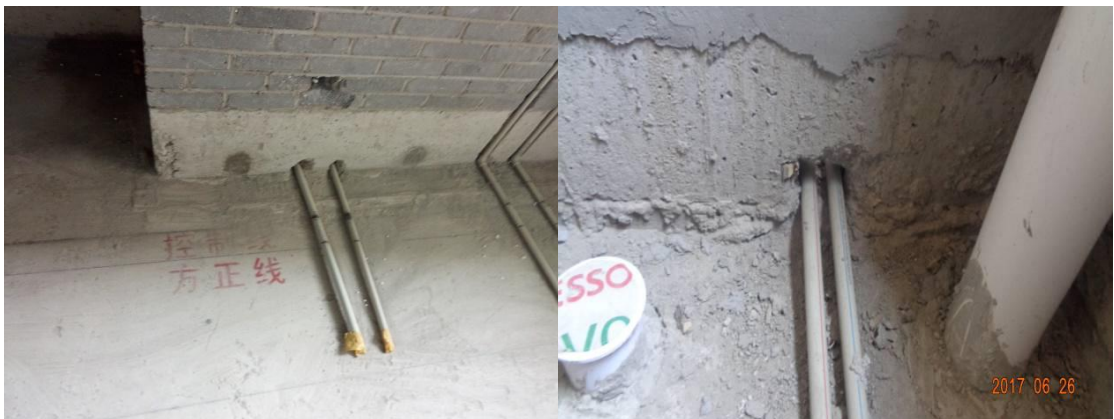
5、卫生间给水管直接从导墙根部穿设。
