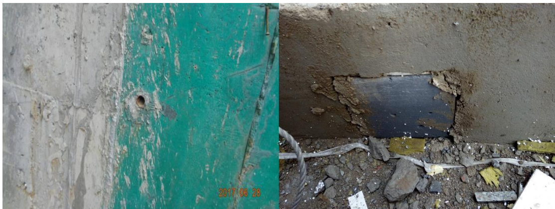
3、外墙孔洞封堵不密实。
