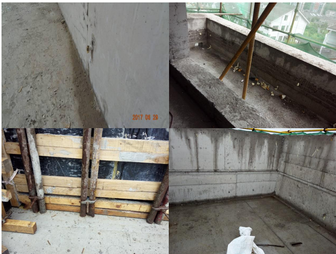
9、施工现场阳楼台部位未设置砼结构导墙。
