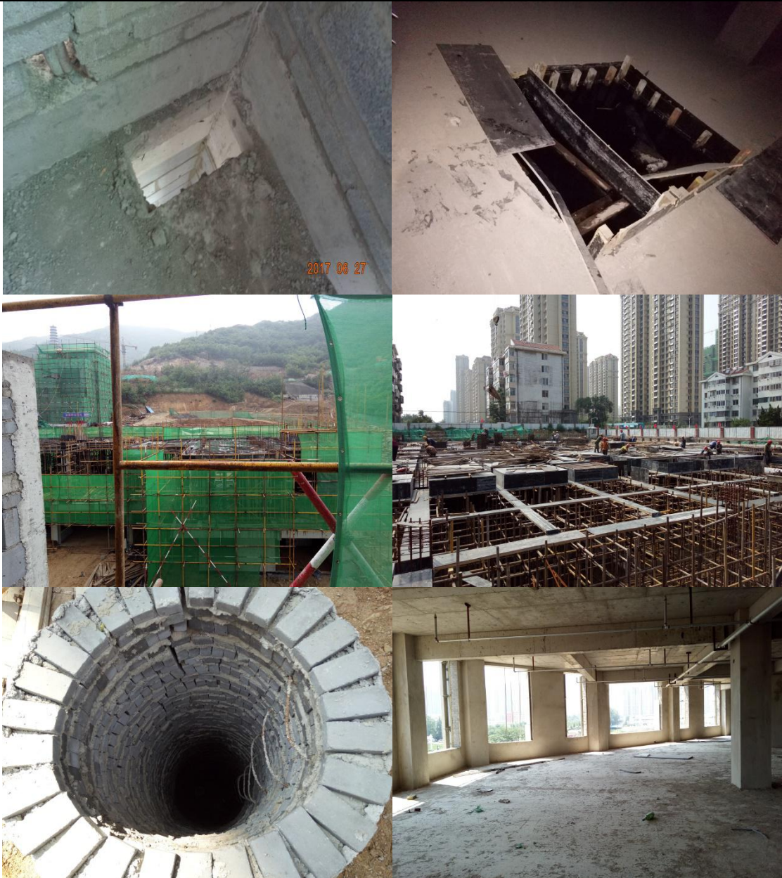
3、外脚手架密目网封闭不严密。
