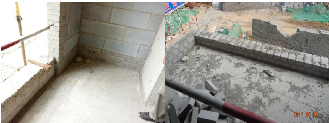
9、施工现场阳楼台部位未设置砼结构导墙。
