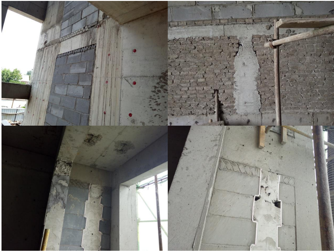
11、现场卫生间基层处理不到位，阴角部位未按照要求设置 R 角。
