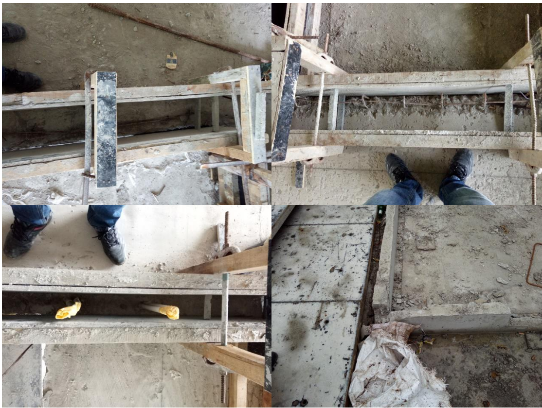
5、卫生间给水管直接从导墙根部穿设。
