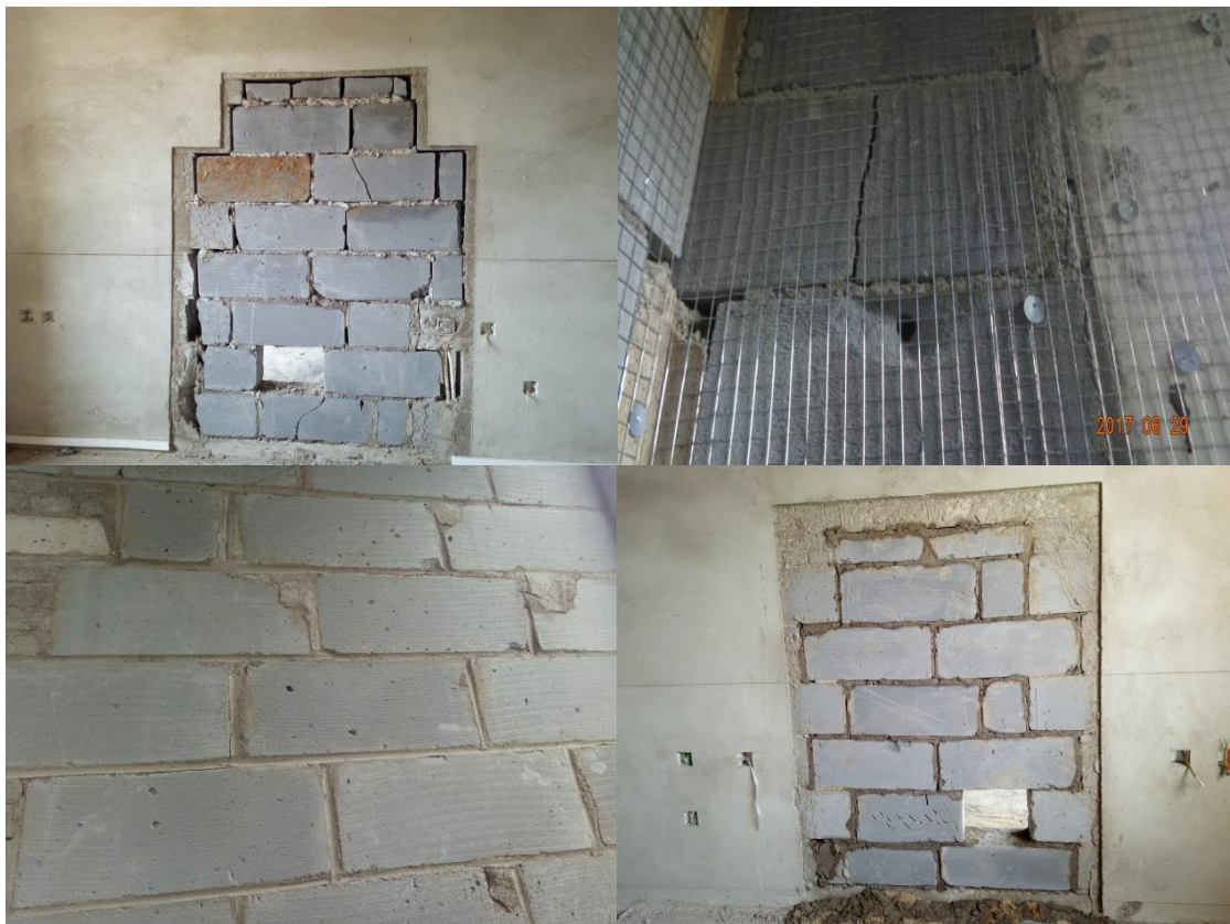
19、现场砌体存在断砖、缺棱掉角、瞎缝、假缝、灰缝大小不一、未双面勾缝等问题。
