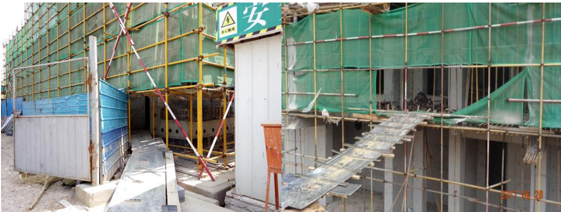
9、施工通道及钢筋加工区域未搭设防护棚或设置不符合要求。
